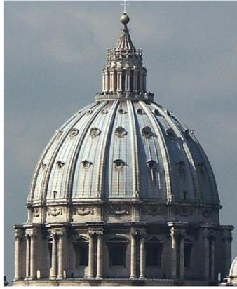
(construcción con ventanas que se dispone sobre una cúpula para dejar que entre la luz). La cúpula puede apoyarse directamente en el muro (caso del *Panteón* romano) o sobre pechinas y trompas, que permiten pasar de un espacio circular a otro cuadrado o rectangular.
