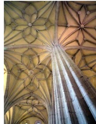
Bóveda de crucería en la que además de los nervios diagonales hay otros en diferentes direcciones que forman estrellas. Es característica del gótico final.
