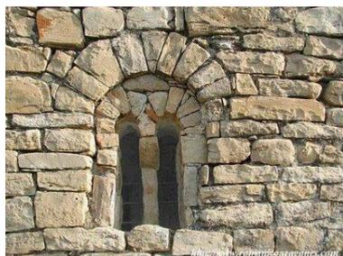
Sillares irregulares, sin labrar, que resultan del poco interés por la construcción o de la mala factura. La pared queda a modo de “huecos” al estar cada arista de forma diferente.
