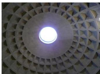
La **cúpula** se apoya sobre un **tambor** cilíndrico con macizos y vanos alternados, arranca de una cornisa situada en la mitad de la altura total del edificio y acaba en un **óculo** redondo de iluminación; al elevarse se adelgaza y aligera gracias al material que se usa (piedra pómez) y a los casetones decorativos (huecos geométricos). Ha resistido hasta ahora gracias a un **complejo sistema de reparto de peso** con un esqueleto interno de arcos de descarga que
