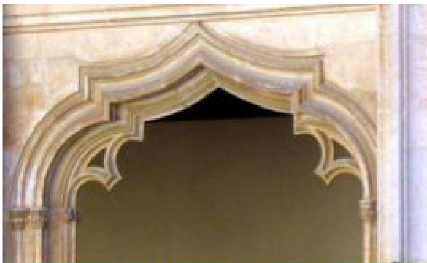
Arco mixtilíneo en el claustro de San Juan de los Reyes. TOLEDO
