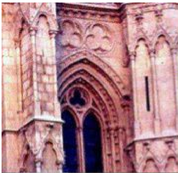
Arcos trilobulados, también llamados TREBOLADOS, en este caso son ciegos, en la fachada de la Catedral de Burgos.
