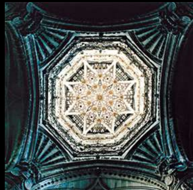
BÓVEDA DEL CRUCERO
