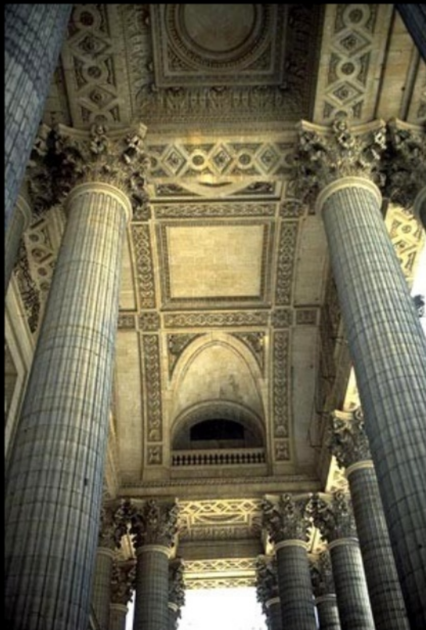
Detalle interior del pórtico
